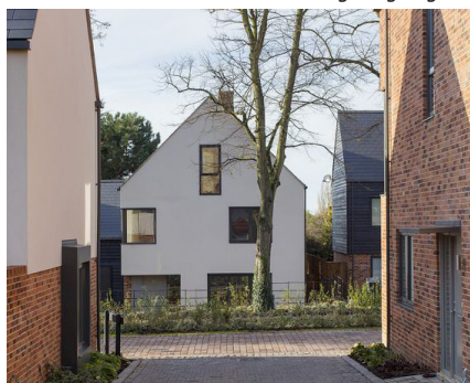
gemêleerd metselwerk met gekeimde gevels
